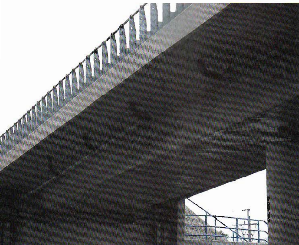
Fot. 2. Kosztowny system odwodnienia obiektu mostowego
