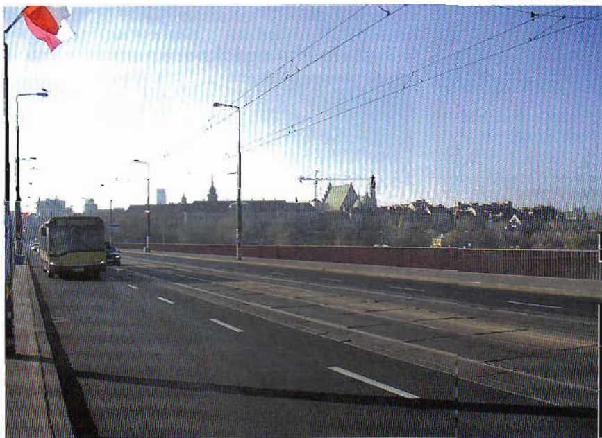
Fot. 1. Nawierzchnia mostu Śląsko-Dąbrowskiego w Warszawie, pierwsza w Polsce w całości modyfikowana elastomerem SBS, rok wykonania 1993.
